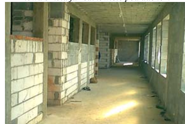
pierwsze zdjęcia z wnętrza budynku – zakończono już roboty wodno-kanalizacyjne, elektryczne, teraz do pracy przystąpili tynkarze.
