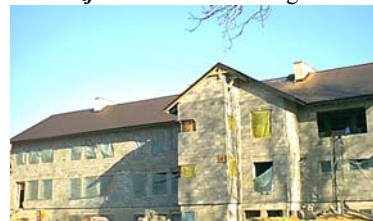
nowa szkoła już całkowicie pod dachem
