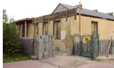
widok starego budynku od bramy wjazdowej (po częściowej rozbiórce)
