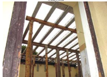
tak wygląda wnętrze budynku – rozbiórki dokonano do wysokości okien dawnego budynku
